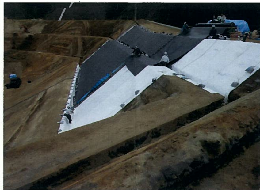
②上の段からシートを引き出して下段部まで展張する。 ※重ね幅等を考慮しながら施工する
