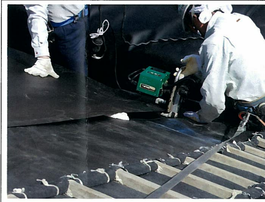
⑥融着機の構造はシートとシートの間にバーナを入れ熱を加えシート上と下から強く押し付け融着させる。 ※重ね部は標準 10cm、接合幅は 3cm以上 ※走行速度は 0.9m/min~2.0m/min
