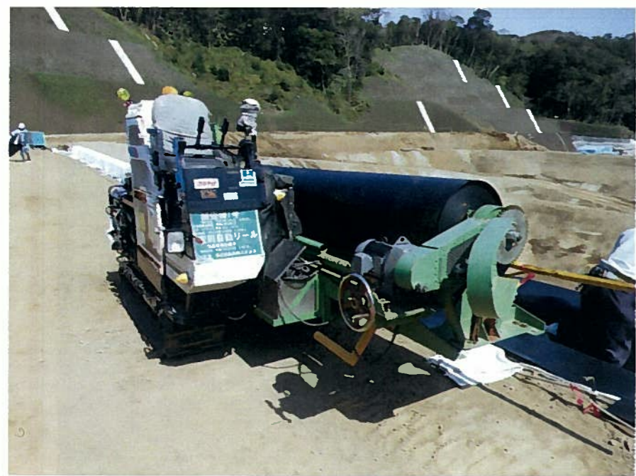
①展張機にロール状のシートをセットする。 ※ロールは幅 5.15m×150m
