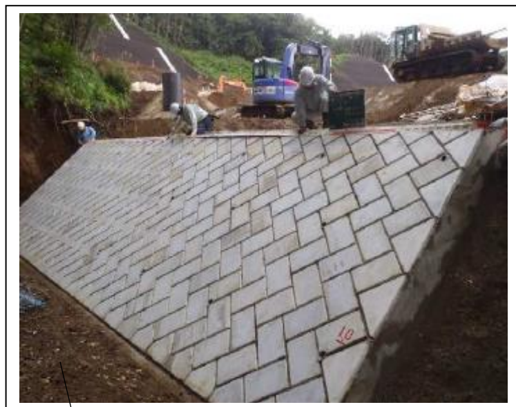
写真1「上流井戸付近ブロック壁」
