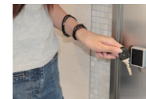
見守り入退館システム
