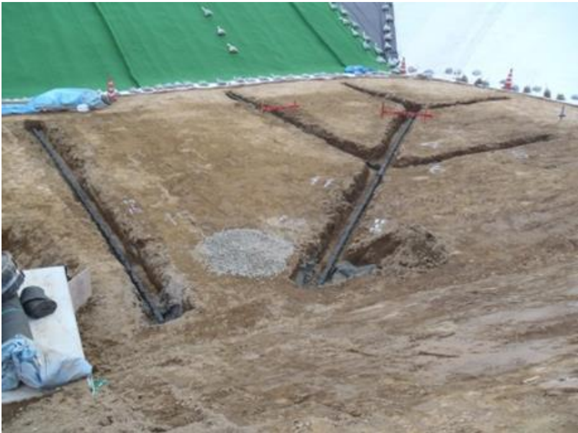
地下水集排出管設置写真
