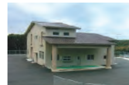
◆ 浸出水処理施設(管理棟)
