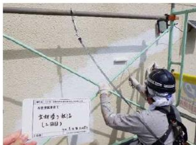
主材塗り(2回目)状況写真
