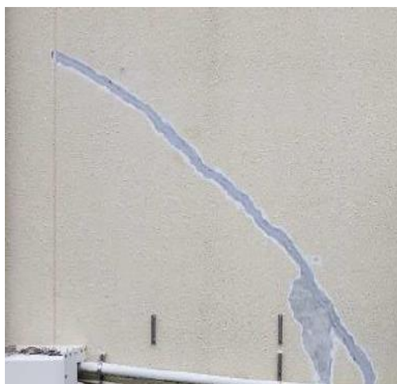
シール充填状況写真
