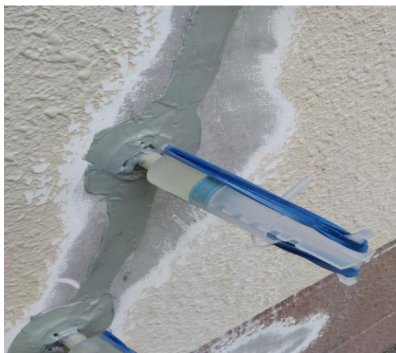
樹脂注入写真
