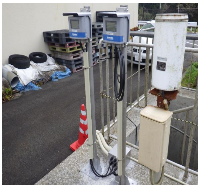
図 10: 地下水ピット計器設置写真
