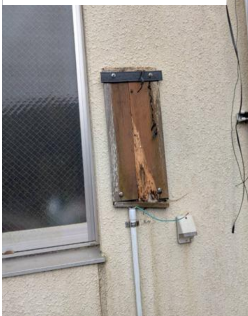
写真 11「取付板交換前(木製)」
