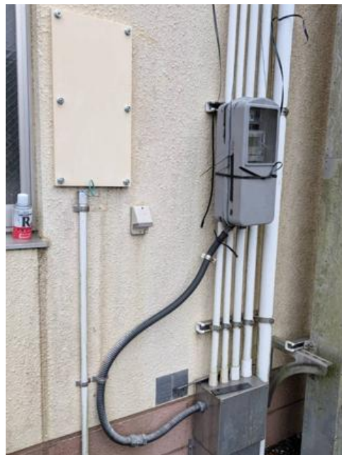
写真 12「取付板交換後(樹脂製)」
