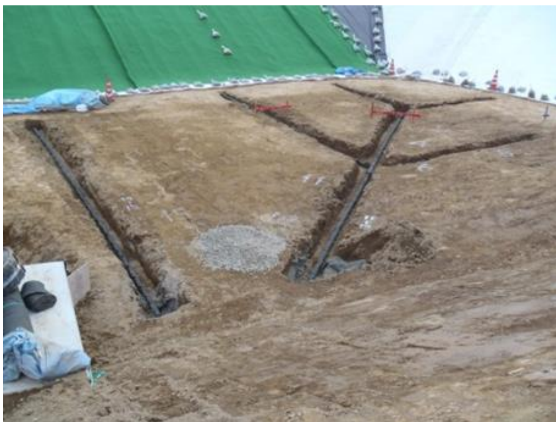
地下水集排出管設置写真
